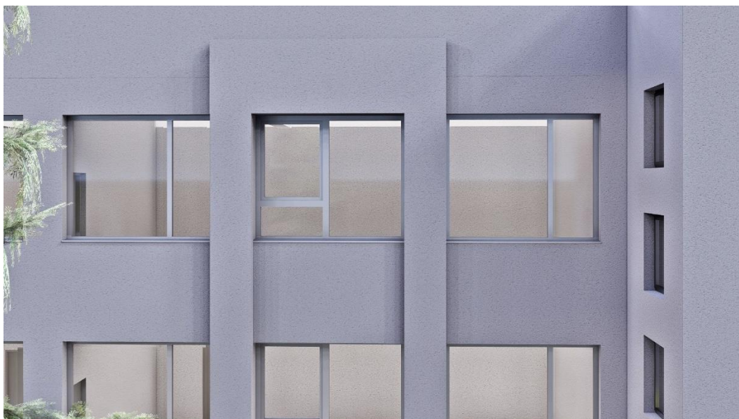
Exemplu de ferestre pe fațada de est cu caracteristici de rezistență la foc EI90 (randare)
