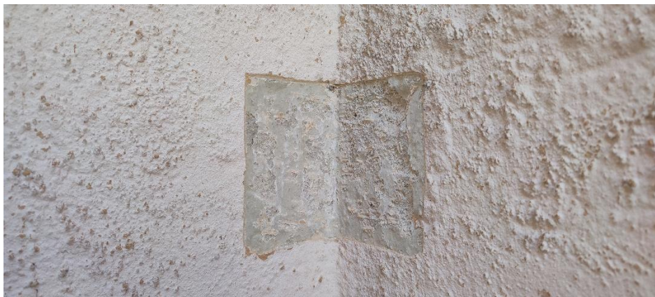
Sondaj stratigrafic, culoarea inițială (verde deschis)
