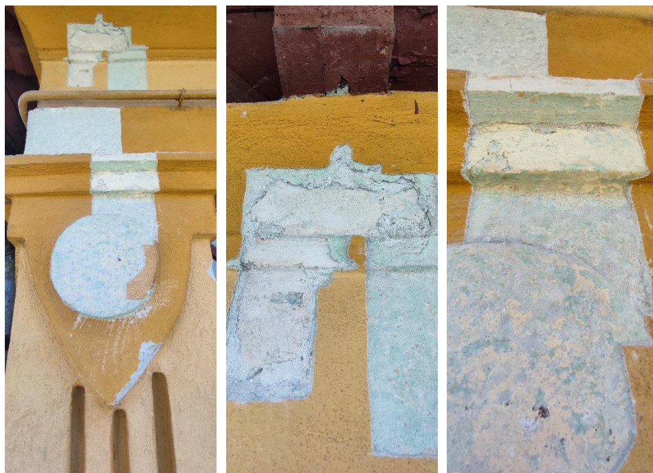
Sondaj stratigrafic, culoarea inițială a ornamentelor arhitecturale, fațada nord-vestic.
