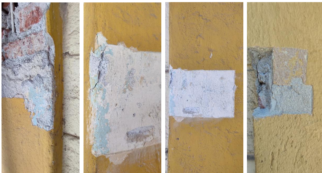
Coloane și profilaturi realizate din cărămidă
