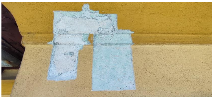
Sondaj stratigrafic, fațada nord-vestic
