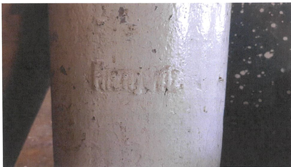
16. Stâlp din fontă din sala de spectacole la etajul clădirii C14
