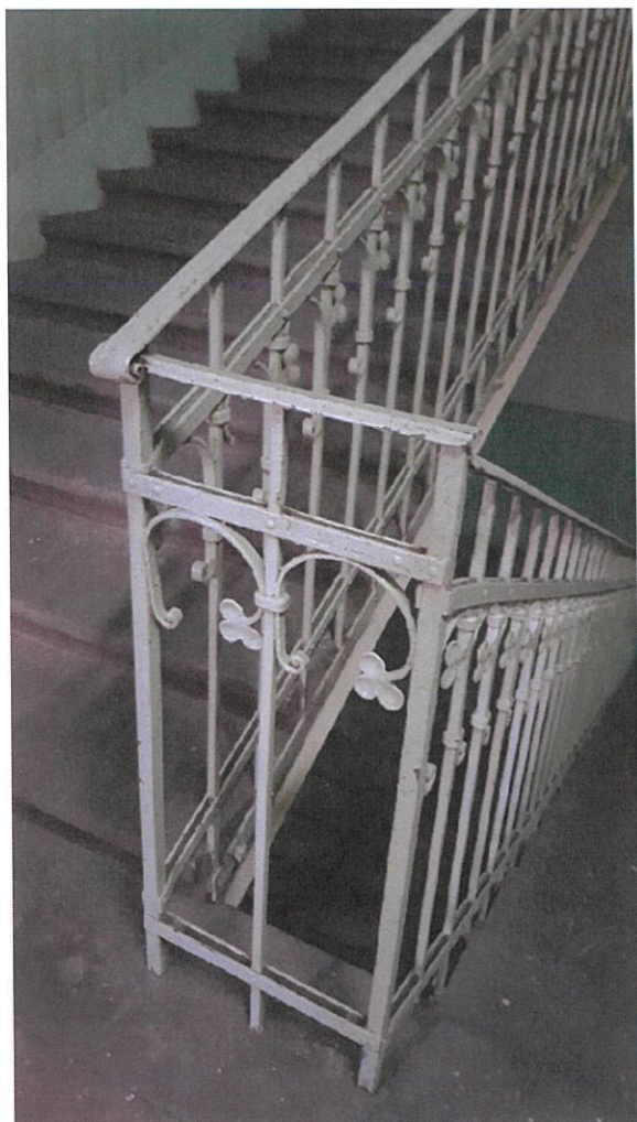
Detaliu de trepte din piatră și parapet din fier forjat, clădirea principală
