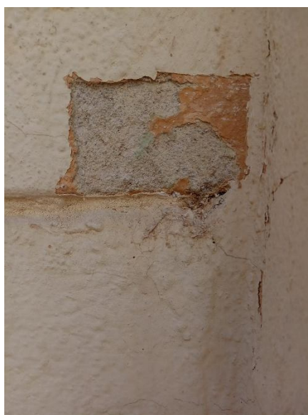
Sondaj stratigrafic, culoarea inițială (verde deschis)
