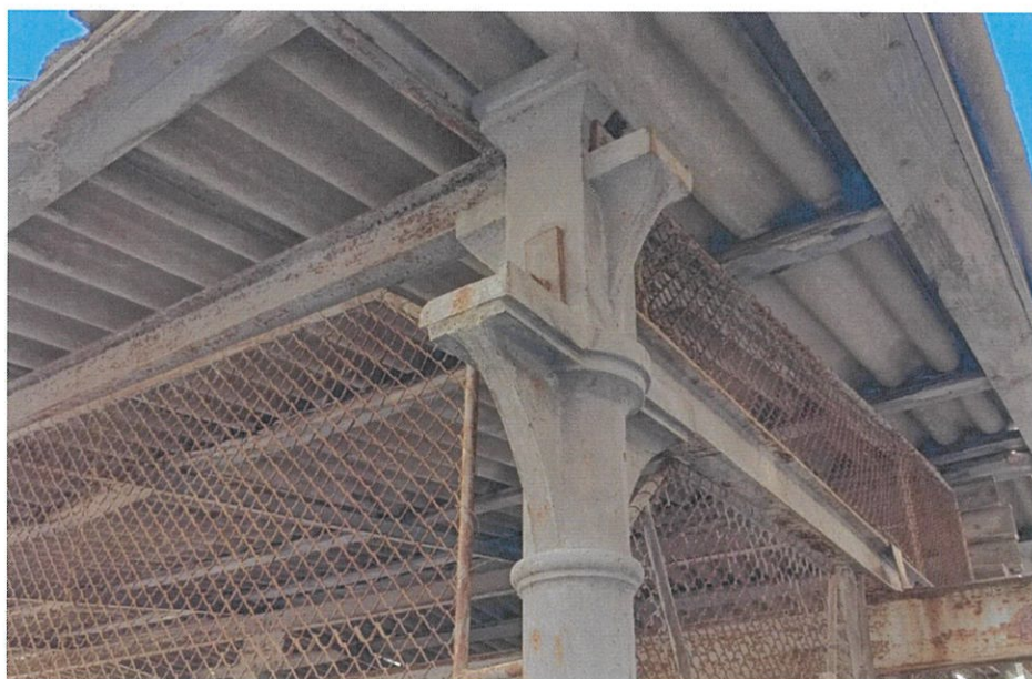
16. Detaliu cu capitelul unui stâlp de fontă, Depozitul C17
