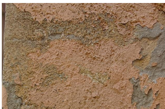
Sondaj stratigrafic, culoarea inițială (ocru deschis), laturile nord-estic, sud-estic și sud-vestic
