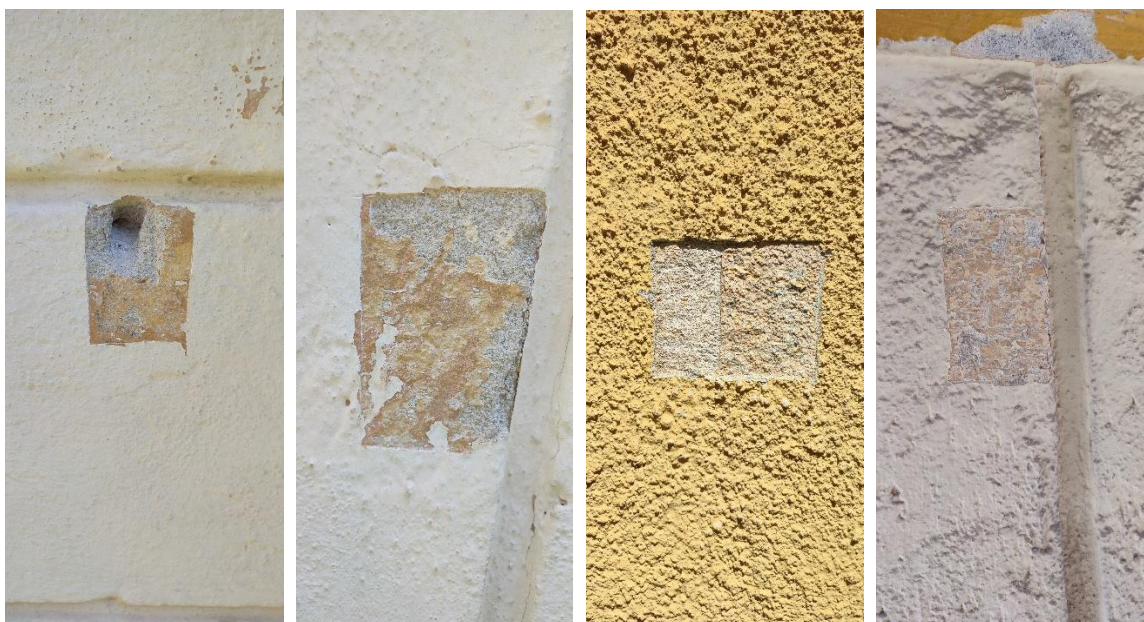
Sondaj stratigrafic, culoarea inițială (ocru deschis), laturile nord-estic, sud-estic și sud-vestic
