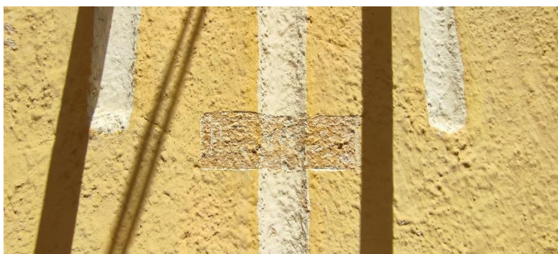
Sondaj stratigrafic, culoarea inițială (ocru deschis), laturile nord-estic, sud-estic și sud-vestic
