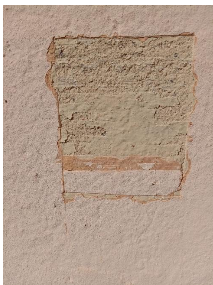
Sondaj stratigrafic, culoarea inițială (verde deschis)
