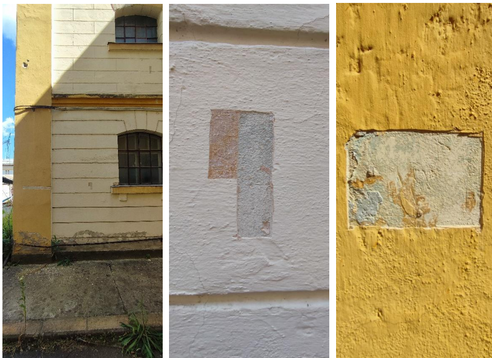
Sondaj stratigrafic, culoarea inițială (verde deschis) a ornamentelor arhitecturale, fațada nord-vestic
