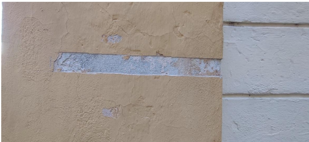
Sondaj stratigrafic, culoarea inițială (verde deschis) a ornamentelor arhitecturale, fațada nord-vestic
