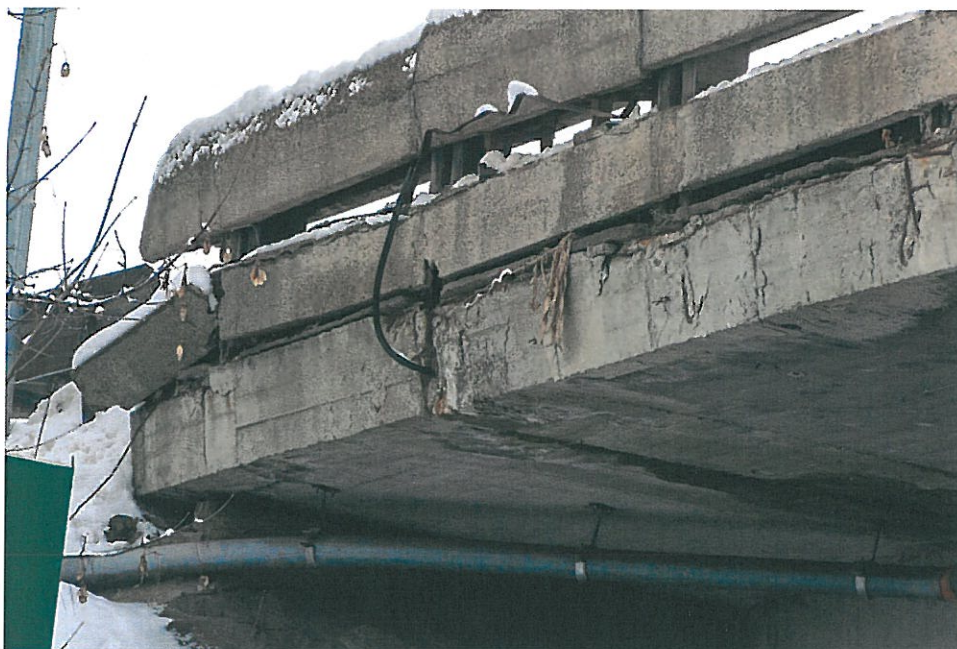
FOTO 8 – Grinda parapetului la culeea C2
