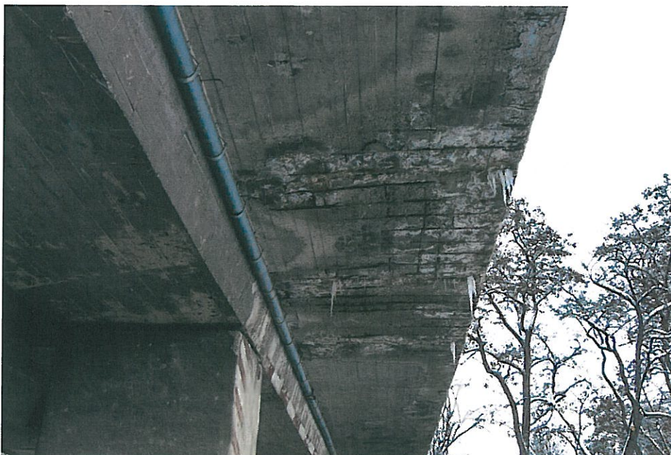
FOTO 7 – Detaliu consola in zona pilei
