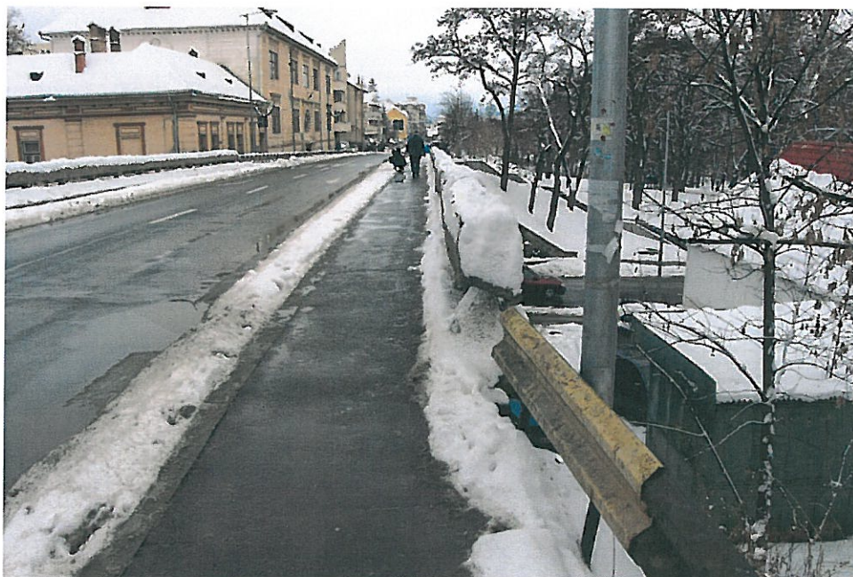
FOTO 14 – Trotuarul si calea pe pasaj
