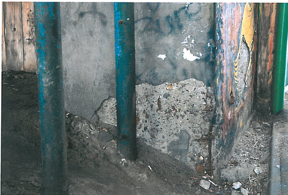
FOTO 11 – Stalpul elevatiei pilei la partea inferioara
