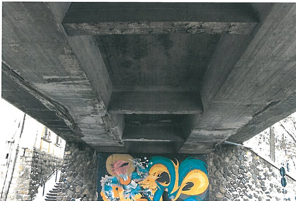
FOTO 4 – Intrados suprastructura spre culeea C1
