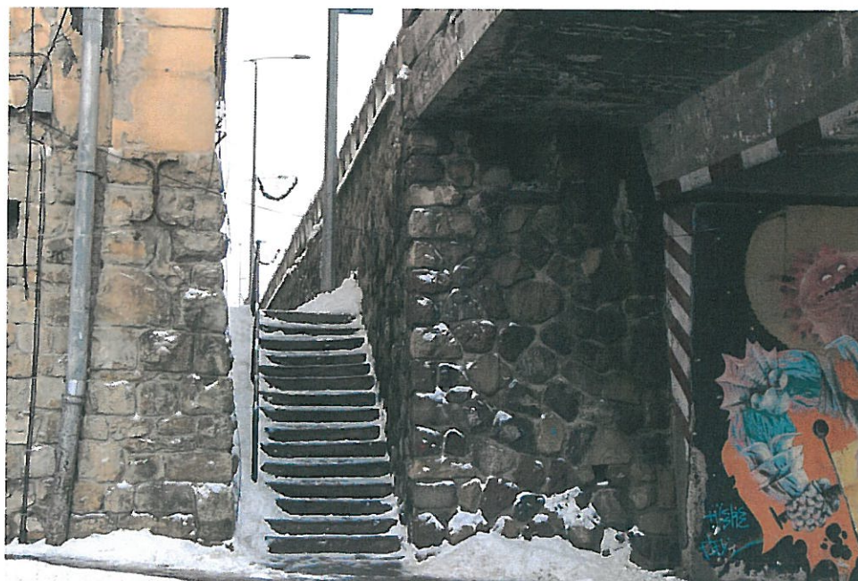
FOTO 18 – Scara de coborare la partea dreapta (spre Prefectura) la culeea C1:
