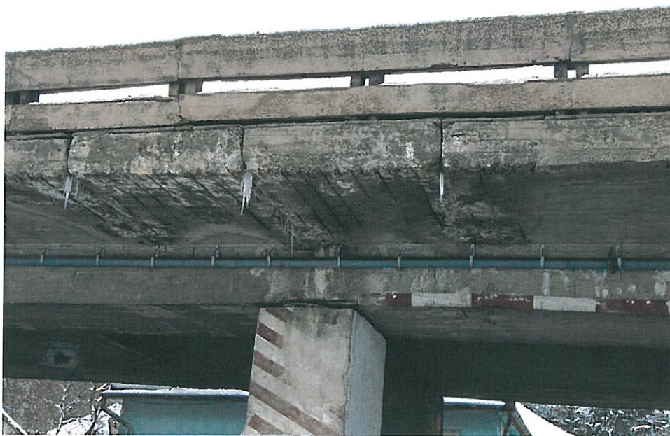
FOTO 12 – Stalpul elevatiei pilei la partea superioara
