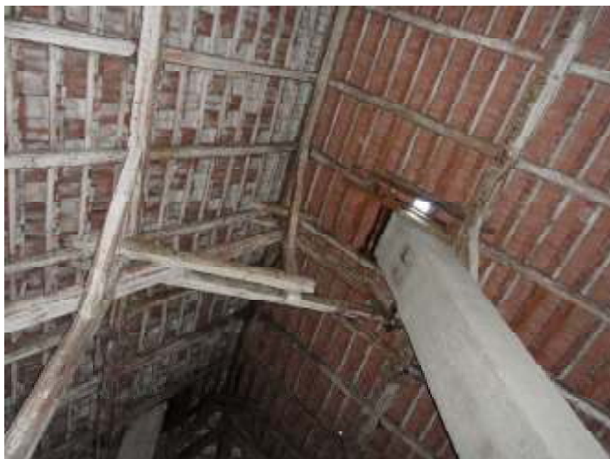
DEGRADARI LA NIVELUL INVELITORII
