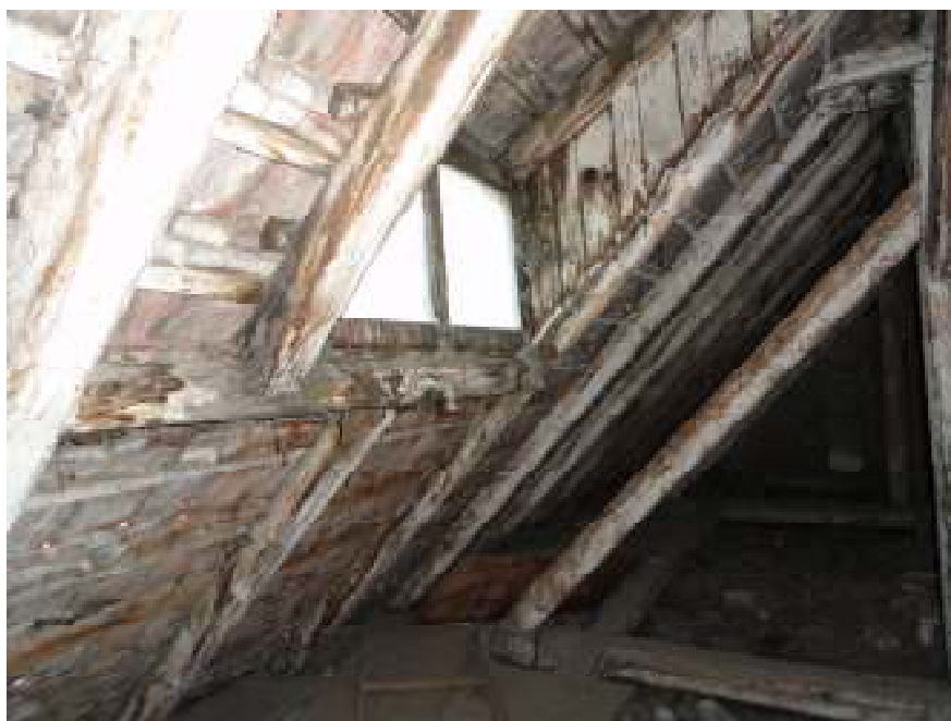
DEGRADARI MATERIALULUI LEMNOS LA LUCARNE
