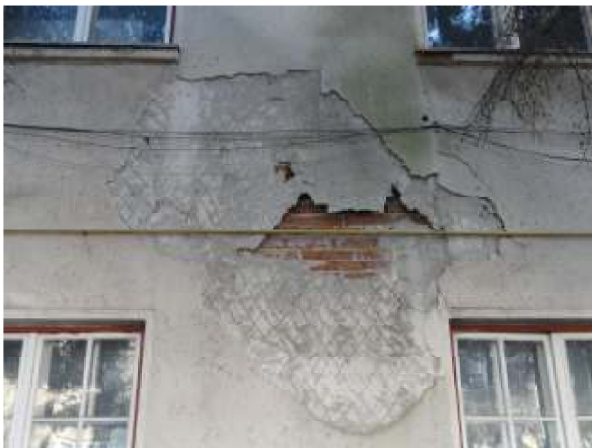
TENCUIALA DEGRADATA PE FATADA NORD-VEST
