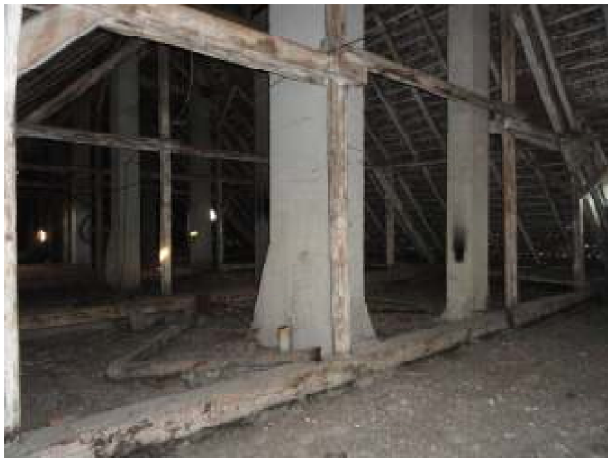
FERMA TRANSVERSALA PRINCIPALA
