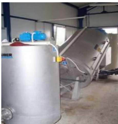
Figura 75 – Instalatie de deshidratare a namolului
