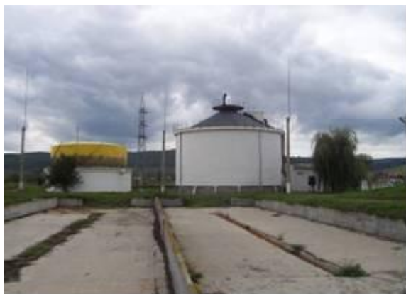
Figura 74 – Metatanc si gazometru
