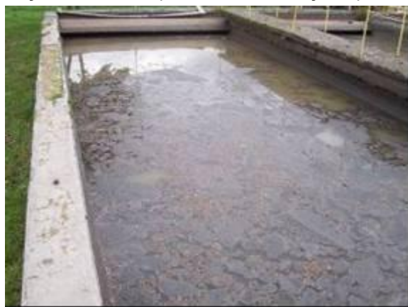
Figura 70 – Decantor primar longitudinal
