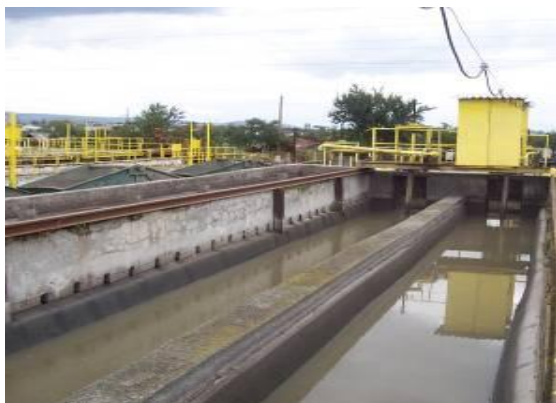
Figura 68 - Deznisipator
