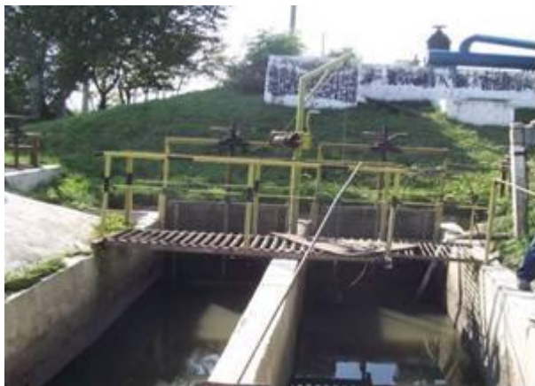
Figura 83 - Deznisipator
