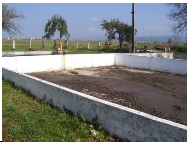
Figura 90 – Platforme de uscare namol
