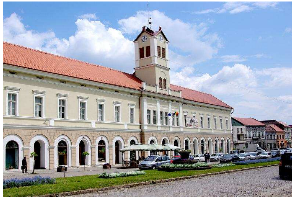
Clădirea reabilitată a Bazarului, astăzi sediul Galeriei de Artă Gyárfás Jenő
